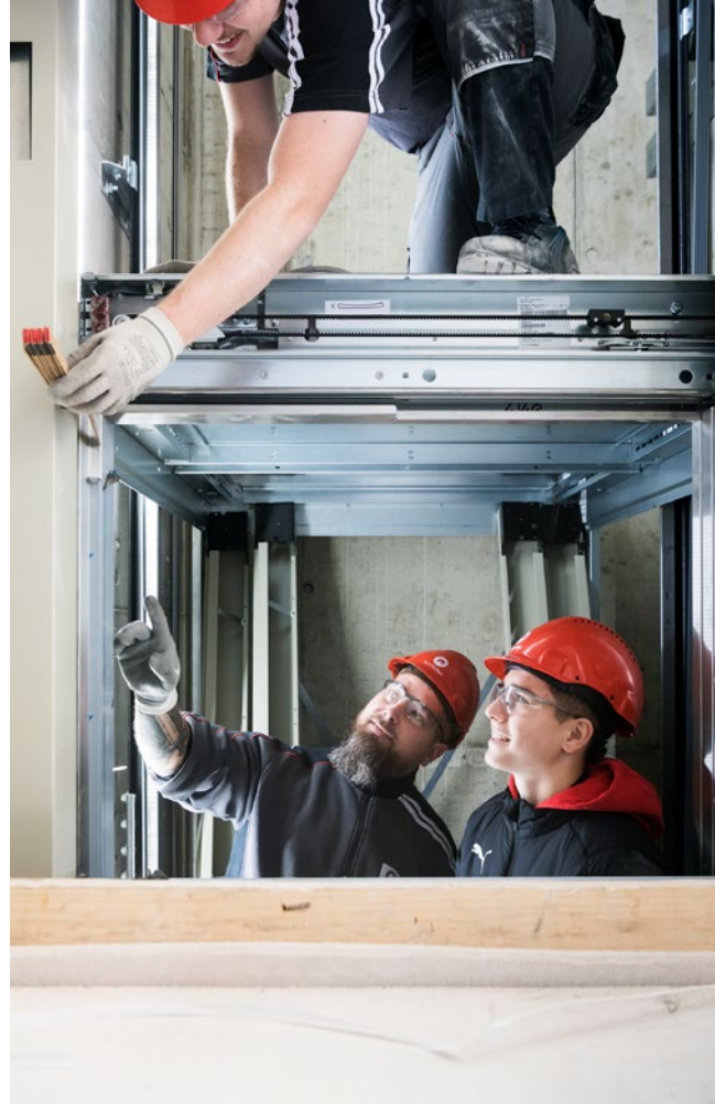
➤ Millimeterarbeit: Betreuer Jens Heuer zeigt seinem künftigen Lernenden, worauf es bei der Liftmontage ankommt.
